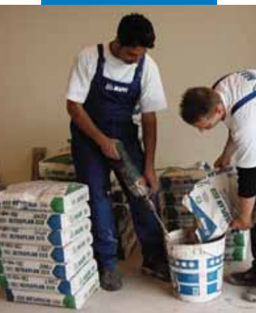
Prepararea sapei autonivelante Ultraplan Eco - Grădinița Mirabello - Cantù (Como) - Italia
