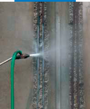
Curățarea barelor de armătură
