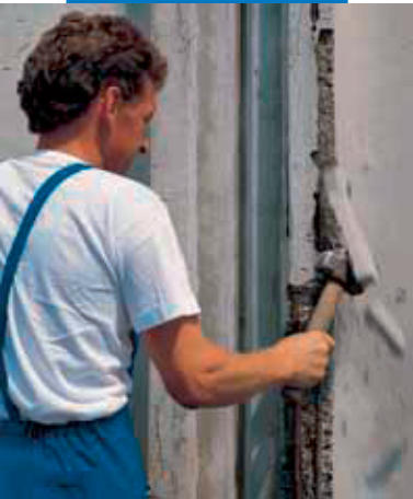
Îndepărtarea betonului degradat
