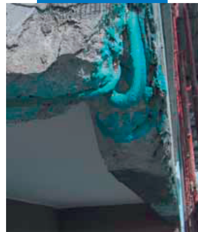
Bare de armătură de pe conturul unui balcon, protejate cu Mapefer 1K
