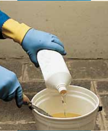
Amestecarea componentelor Epojet
