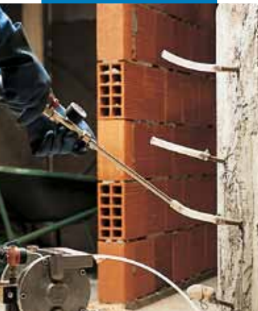
Injectarea fisurilor la un stâlp cu Epojet
