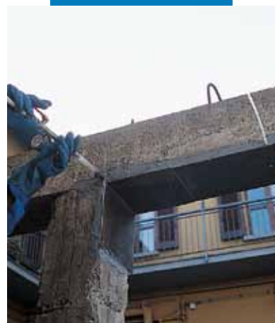
Repararea unei grinzi prin injectare cu Epojet
