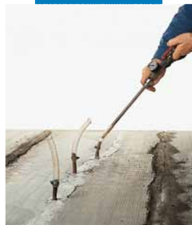
Refacerea unei structuri orizontale prin injectare cu Epojet
