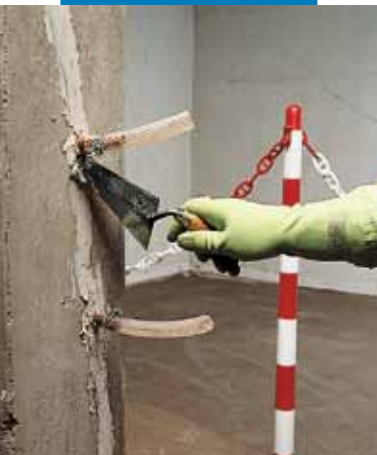
Fixarea tuburilor de injectare cu Adesilex PG1
