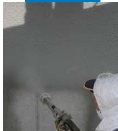
Exemplu de aplicare Mapelastic prin torcretare la un viaduct
