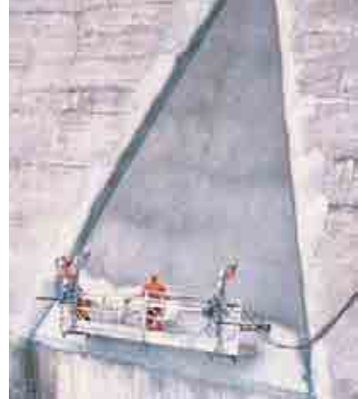
Exemplu de aplicare Mapelastic prin torcretare la un baraj
