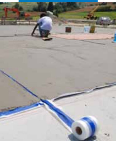
Hidroizolarea șapelor cu Mapelastic și Mapeband
