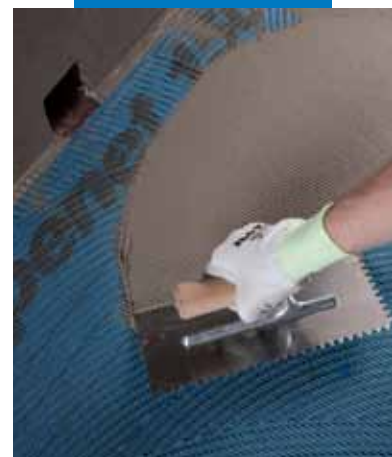
Aplicare Mapelastic pe Mapenet 150
