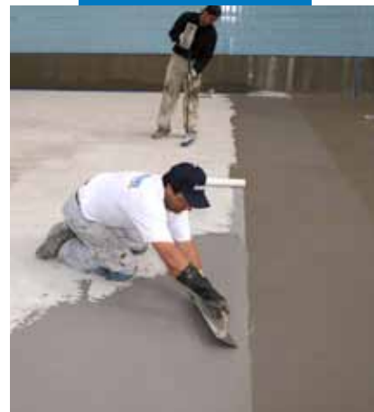
Hidroizolarea unei piscine cu Mapelastic
