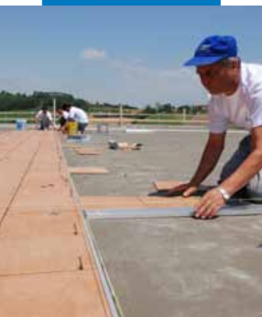
Instalarea plăcilor ceramice cu Kerabond + Isolastic
