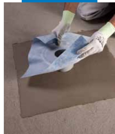
Montarea elementului de scurgere, Drain Vertical, pe Mapelastic
