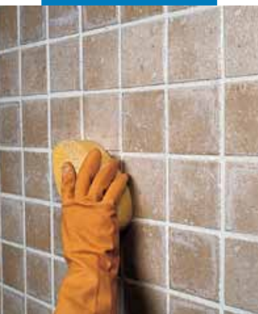
Finisarea și curățarea finală a plăcilor folosind buretele dur de celuloză Mapei
