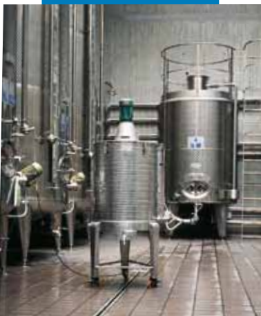
Exemplu de chituire a rosturilor pardoselii unei fabrici de prelucrare a vinului
