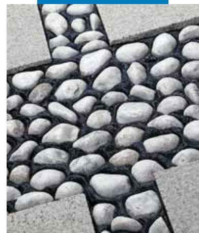
Exemplu de lipire și chituire pentru placaj cu pietre ornamentale
