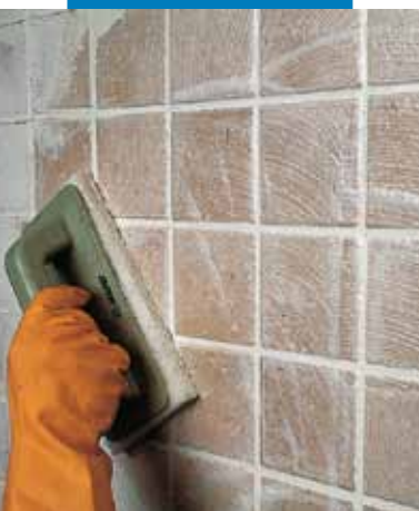
Emulsionarea chitului de rosturi cu ajutorul padului abraziv tip Scotch-Brite®
