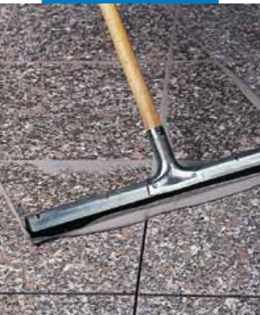
Chituirea unei pardoseli din dale de granit semilucios, cu ajutorul unei raclete
