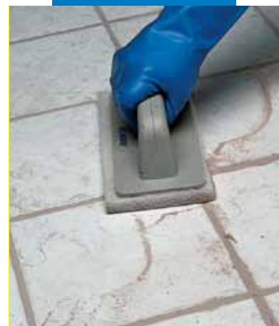
Finisarea cu un pad abraziv tip Scotch-Brite®
