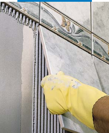
Aplicarea de placi portelanate pe un perete tencuit
