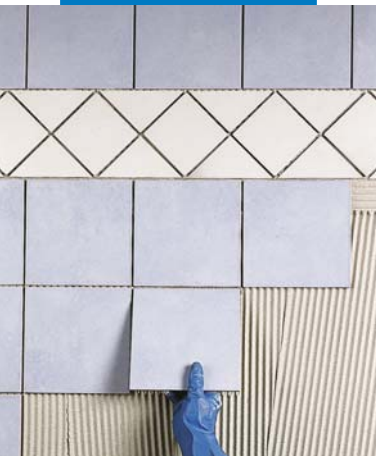
Aplicarea de placi portelanate pe un perete din gips-carton
