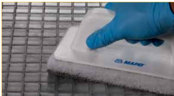
Drișcă cu pad alb Scotch Brite® pentru emulsionarea chitului de rosturi epoxidic
