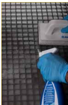
Aplicarea cleaner-ului Kerapoxy Cleaner pentru produse epoxidice
