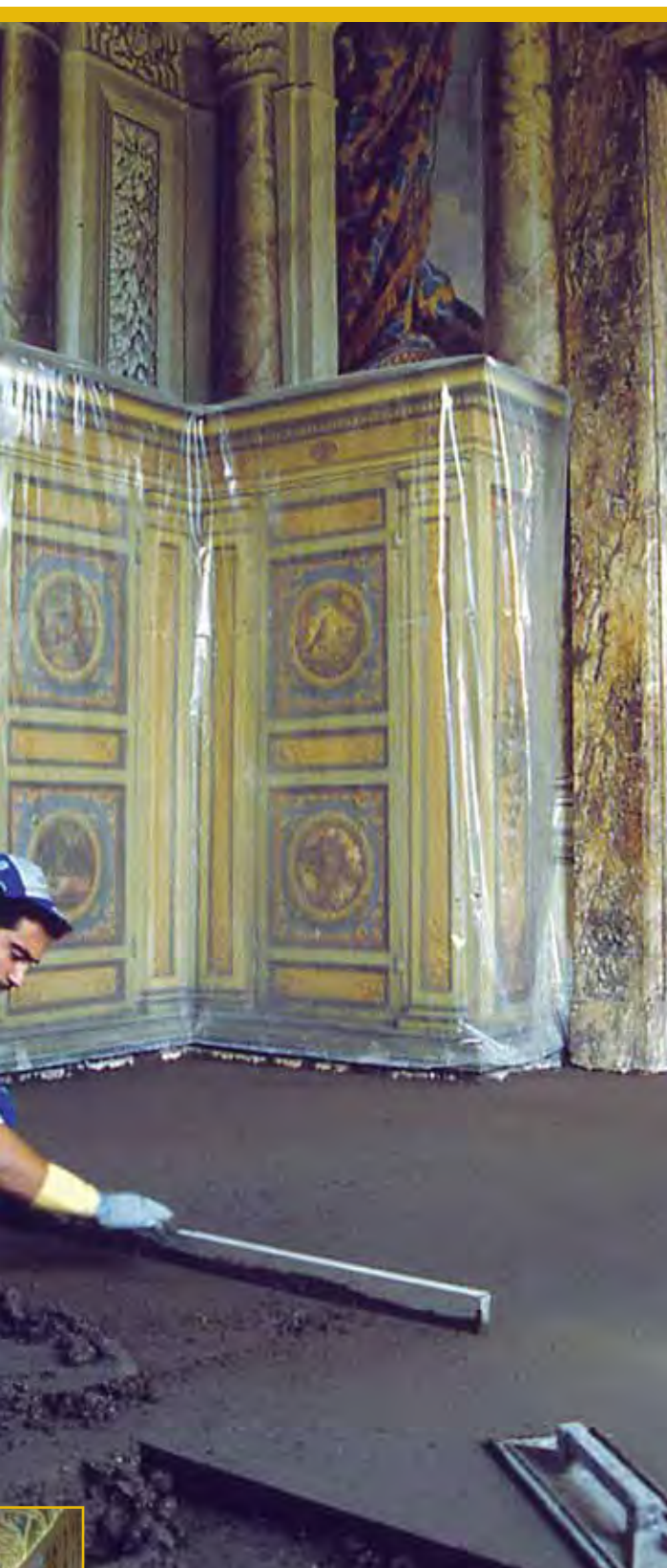
CAPELA SIXTINĂ - Vatican Produse utilizate: GRANIRAPID, ULTRACOLOR și MAPEFLEX PU21 au fost utilizate la montarea plăcilor de gresie portelanata peste șapa MAPECEM
