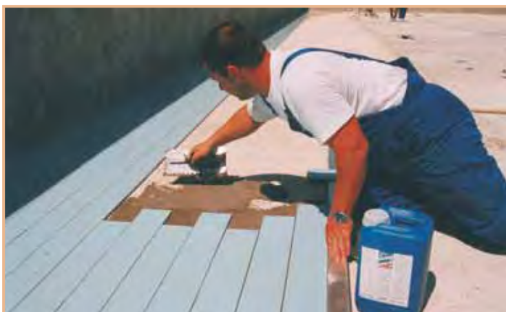
Fig. 2 Test de lipire pe un strat adeziv
