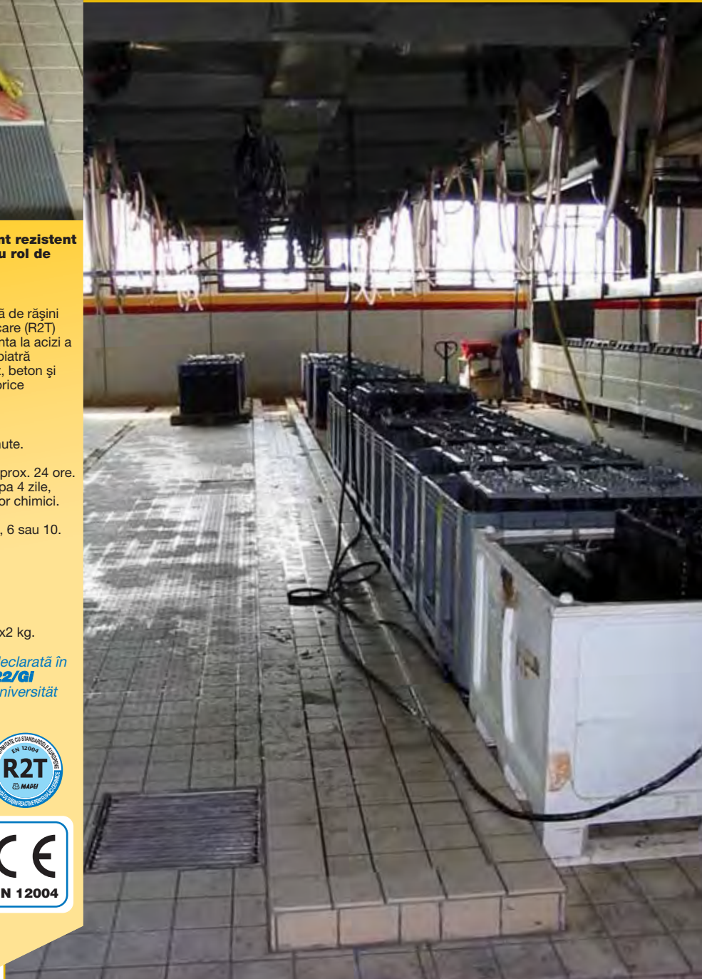
FAAM-IBF - Monte Sant'Angelo - Italia Produse utilizate: TOPCEM PRONTO, PLANICRETE, KERAPOXY, KERAPOXY P, MAPEBAND, MAPEFLEX PU30
