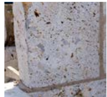
Reconstrucția unui perete expus
