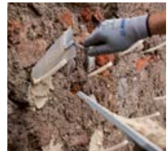
Chituirea golurilor rămase după îndepărtarea tuburilor subțiri de injectare
