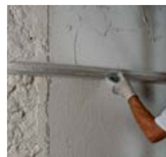
Compactarea tencuielii de asanare cu dreptarul
