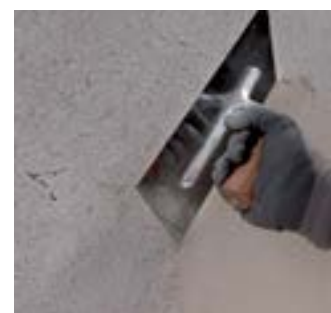
Aplicarea unui mortar de gletuire cu textură grosieră
