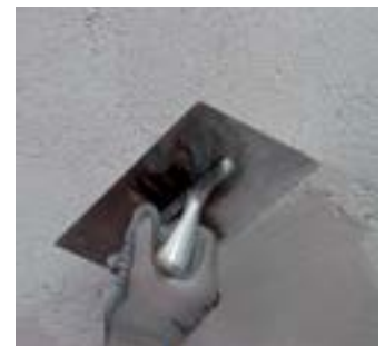
Aplicarea unui mortar de gletuire cu textură fină
