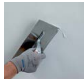
Aplicarea celui de-al doilea strat de mortar ultrafin
