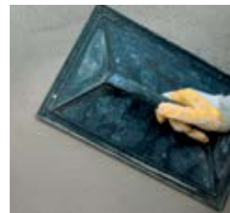
Nivelarea unei tencuieli permeabile
