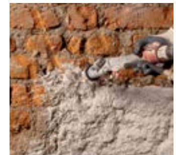
Aplicarea unui strat punte de aderență cu mașina de tencuit
