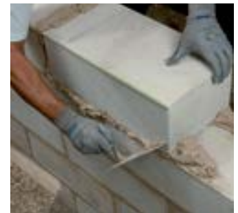
Construirea unui zid din piatră
