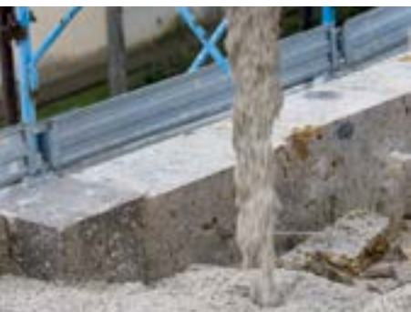
Turnarea mortarului în cofraj
