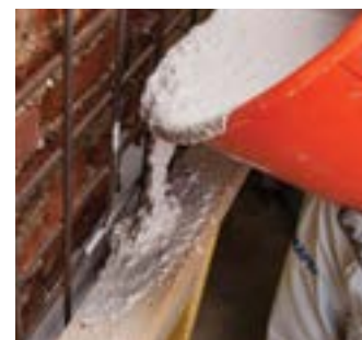
Turnarea mortarului realizat din Mape-Antique Hi-Flow și agregate 4-8 mm
