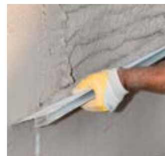
Compactarea unei tencuieli permeabile cu dreptarul
