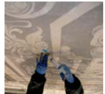
Restabilirea aderenței între zidărie și tencuiala frescei
