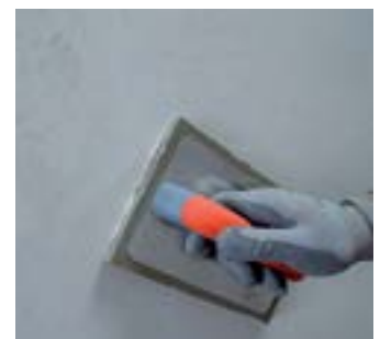
Finisarea suprafeței cu drișca cu burete
