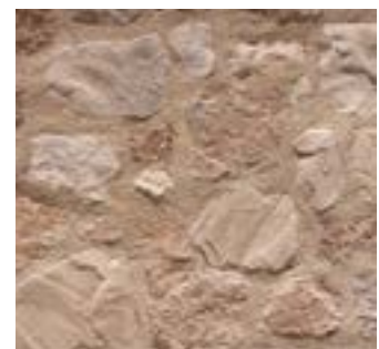
Reconstrucția unui perete expus
