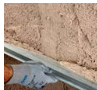
Compactarea tencuielii de asanare cu dreptarul
