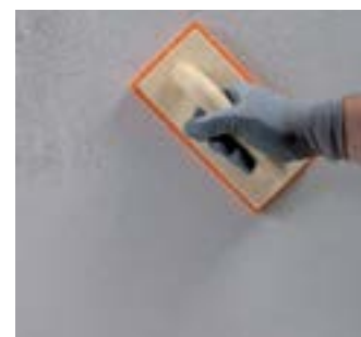
Finisarea suprafeței cu drișca cu burete
