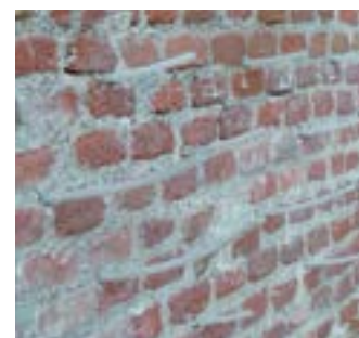
Consolidarea unui perete din zidărie
