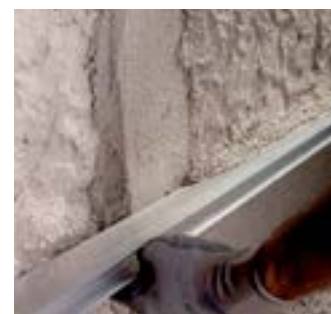
Compactarea tencuielii de asanare cu dreptarul
