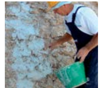
Aplicarea unui strat punte de aderență cu spatula
