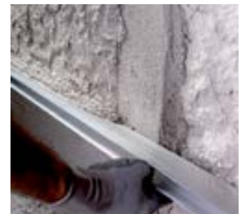
Compactarea tencuielii de asanare cu dreptarul
