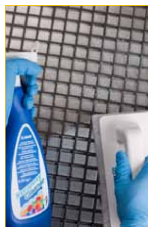
Emulsionarea chitului epoxidic de rosturi cu drișcă cu pad abraziv Mapei
