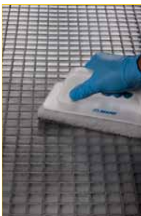
Emulsionarea chitului de rosturi cu drișcă cu pad abraziv Mapei
