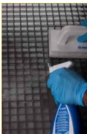
Aplicarea cleaner-ului Kerapoxy Cleaner pentru produse epoxidice
